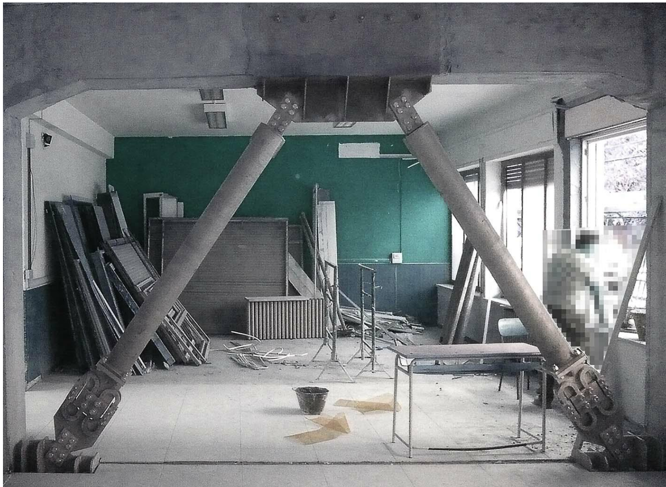
Installazione di controventi dissipativi
